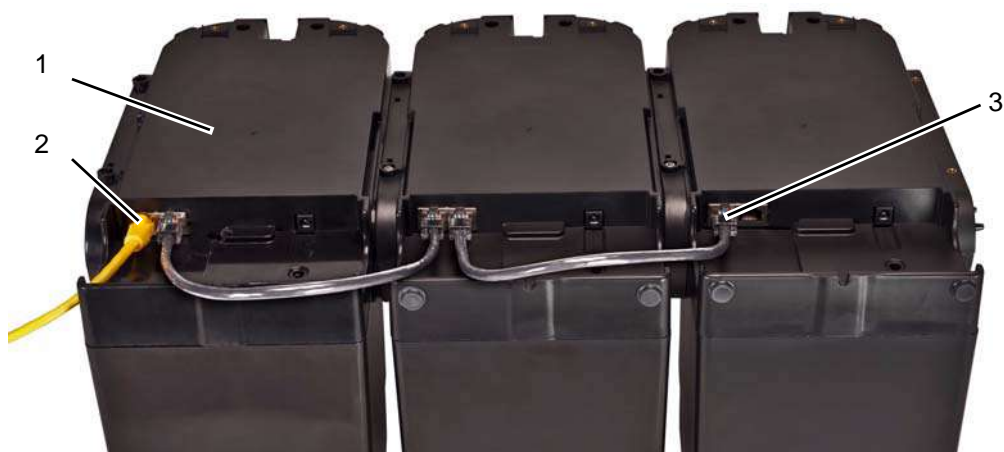
Fig. 11 Conexiones Ethernet de la estación de prueba
